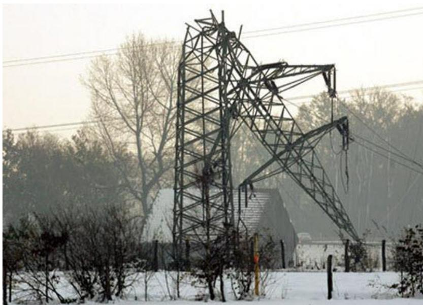
**Рис. 15.** Авария на ЛЭП в результате стихийного бедствия, приводящая к долговременным перерывам электроснабжения
